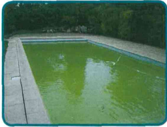
L'eau de cette piscine a été envahie par des algues vertes, du fait d'une désinfection insuffisante.
