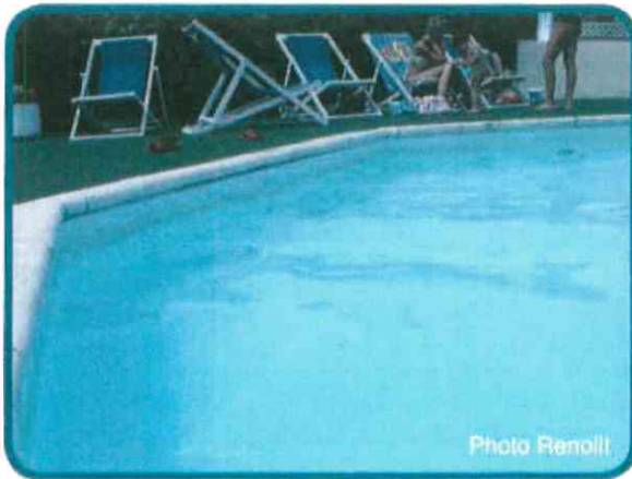
Formation de taches roses violacées, dues à la présence de bactéries ( Rectoverticillium ), entre la membrane PVC-P et le bassin.
